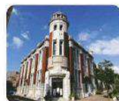
旧古河鉱業若松ビル 若松区幸町
