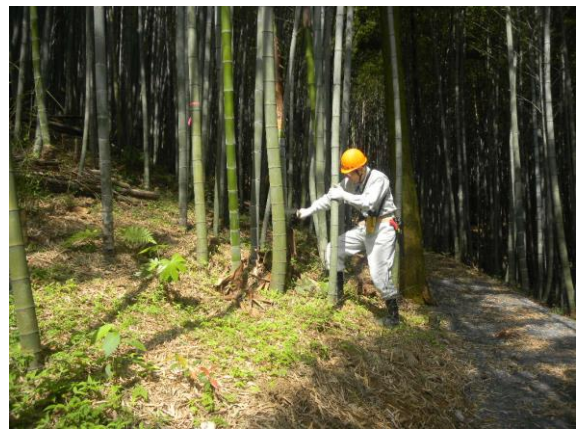
伐竹作業の様子
