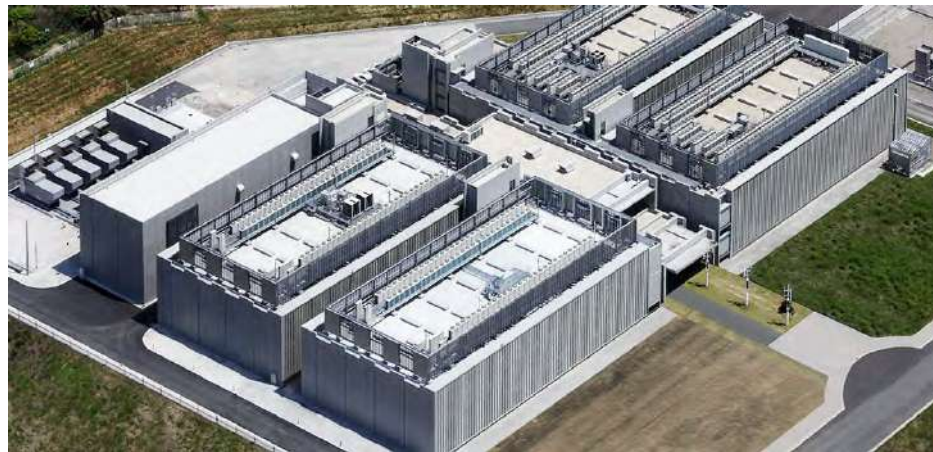
上空からみた福岡北九州データセンター
