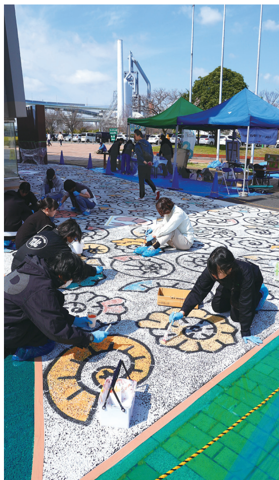
▲ 作業現場の様子。東田第一高炉跡のモニュメントが見守っているようだ
