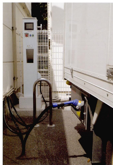
冷蔵・冷凍車のアイドルストップ中も温度管理を可能にする「ファミリーマート」と「タカミヤ」設置の充電ボール
