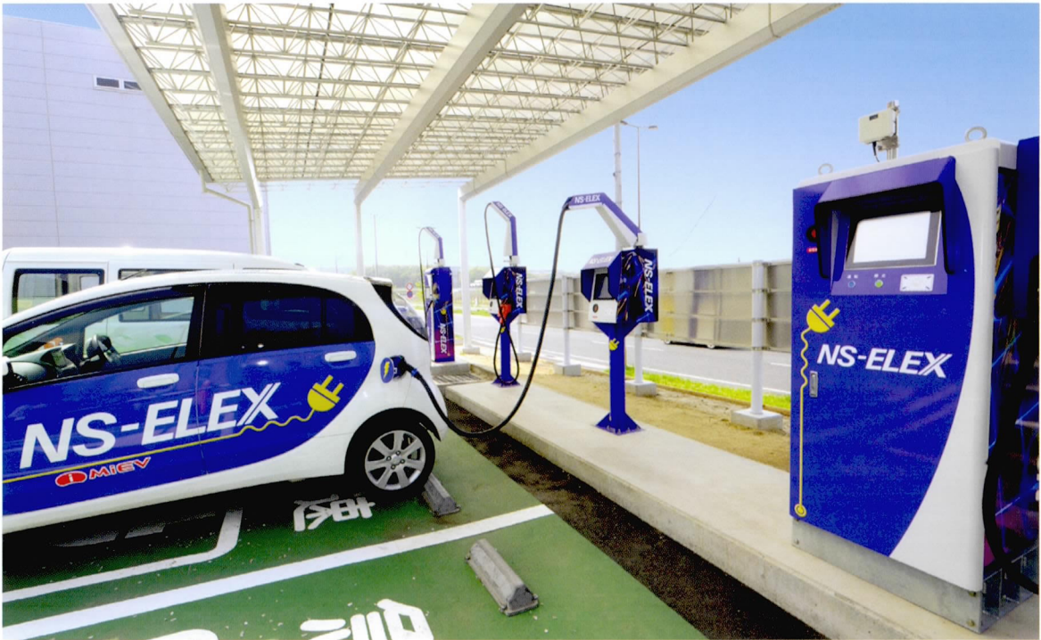
スケジュールや走行距離に応じて効率的な充電を行う「日鉄住金テックスエンジニア」の急速EV充電器
