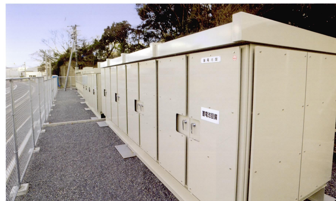
コミュニティ設置型蓄電システム (300kw)
