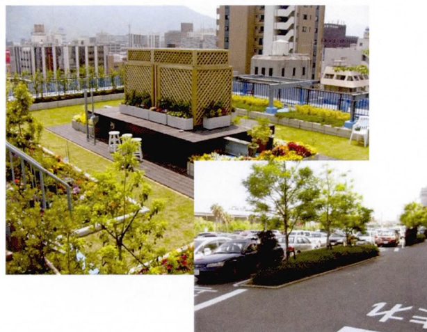
屋上や駐車場の緑化による微気象の緩和
